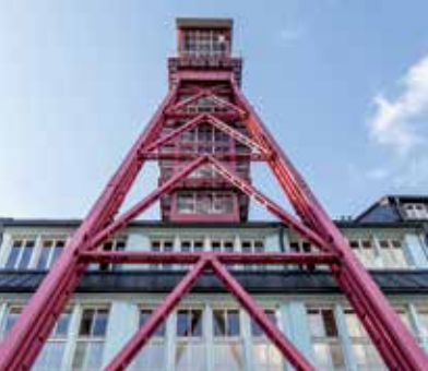
Arno-Lippmann-Schacht (fosse), Altenberg (élément 1)
