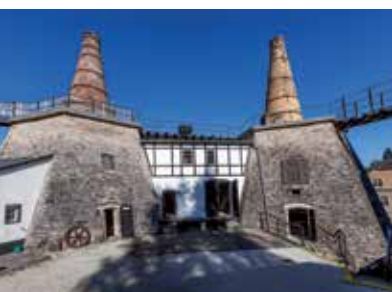
Usine à chaux de Lengfeld (élément 2)
