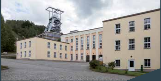
Schachtkomplex 371 bei Bad Schlema (Element 38)
